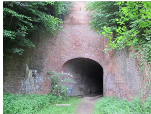
Tunnel onder de Bosstraat (R18)
