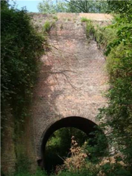
Tunnel onder verlengde Terhagenlei (R16)
