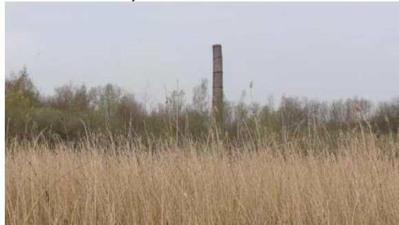
Schoorsteen machineconstructieplaats Landuyt (R06)
