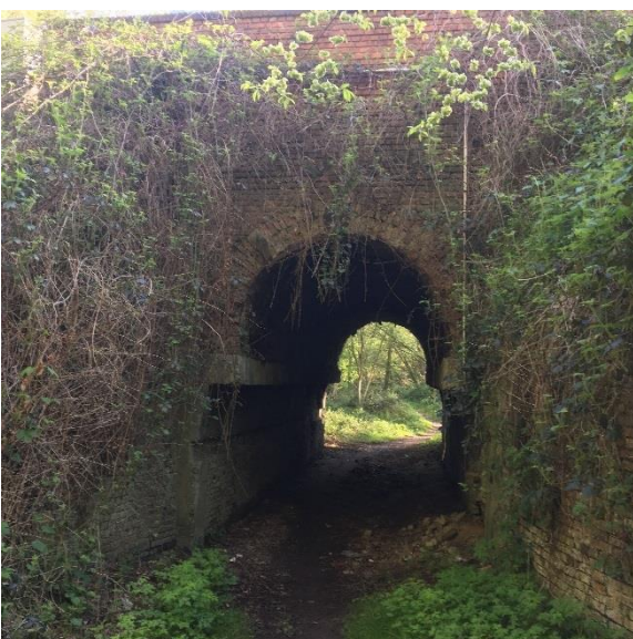
Tunnel onder Kapelstraat
