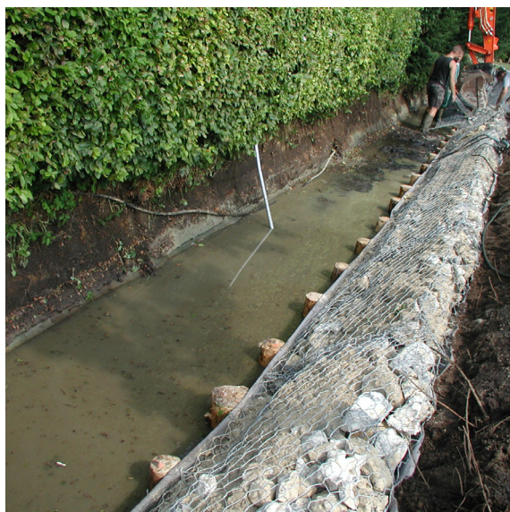
Oeverversteviging met schanskorven (metalen gaasnet gevuld met steenachtige materialen)
